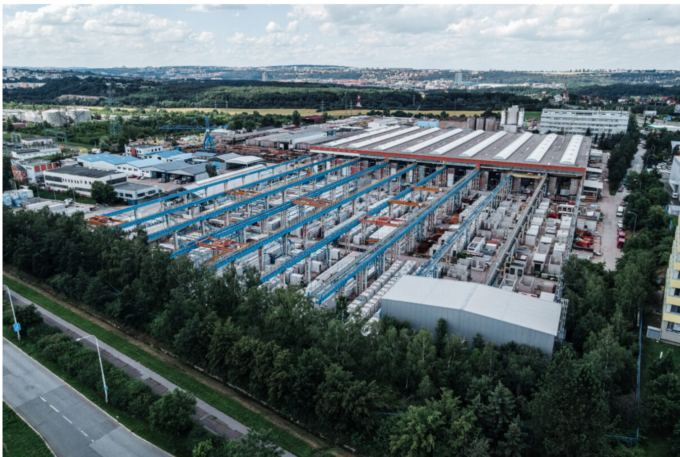
Výrobní závod GRITEC Praha
